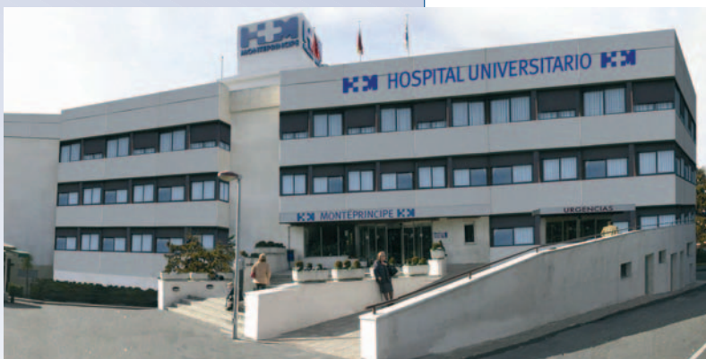
Fachada principal del Hospital Universitario Madrid Montepríncipe.
