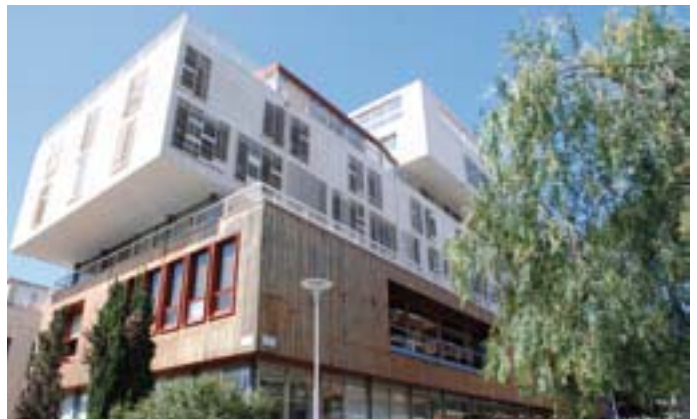
El actual edificio del COMB, inaugurado en 1968, supuso un hito en la Barcelona arquitectónica de la época.
